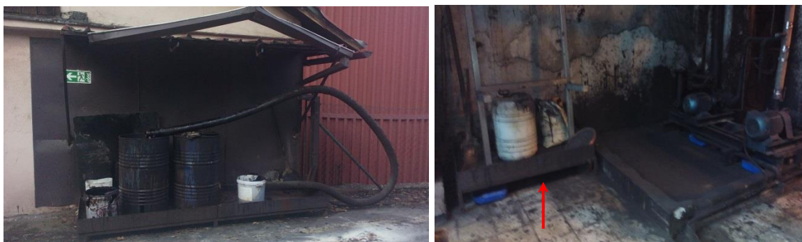
Слика 19. Приказ једног од места у котларници и изнад ње на коме долази до издвајања мазута и приказ буради за његово сакупљање (адекватно постављена импровизована таквана)
